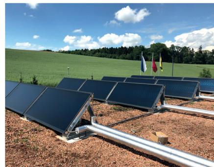
Thermische Solaranlage, die perfekte Ergänzung zu einer Holzschneitzel-Wärmeezeugung (realisiert für eine Schulhausanlage gemäss Wärmeezeugungskonzept)
